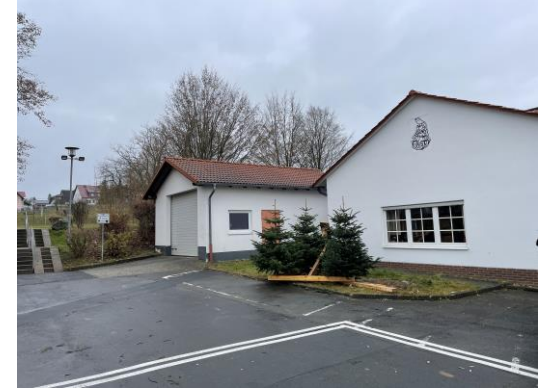
Feuerwehr-GH mit dahinterliegenden Vereinsgebäude und Treppe zum Bürgerhaus
