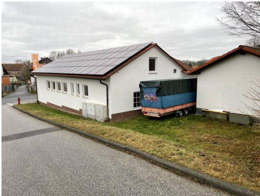
Zufahrt „Steinweg“ zur Anlieferung Bürgerhaus Feuerwehr-GH mit Vereinsgebäude im Vordergrund
